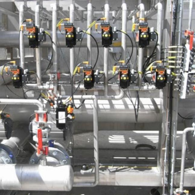
Автоматизированные вентили для агрохимического оборудования
